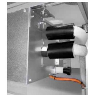
Dämmung der Anschlüsse sorgfältig ausführen, um Kondensat zu vermeiden (nach DIN EN 378)
