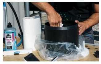
Reinigen Sie die Schweissflächen des Fittings und der Rohre mit dem PE-Reiniger Tangit und einem sauberen Tuch.
