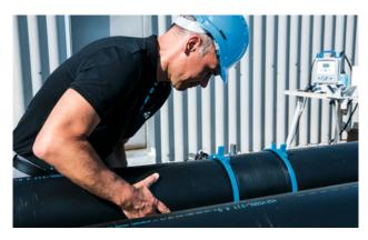
Schieben Sie beide Rohrenden bis zur Markierung in das Fitting. Ziehen Sie die Montagehilfe danach wieder ab.
