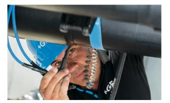
$\label{thm:chweisskontakten} Verbinden Sie die Schweisskabel \ mit \ den Schweisskontakten \ des \ Fittings \ und \ schweissen \ Sie \ gemäss \ Anleitung.$
