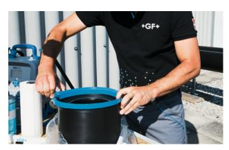
Stecken Sie die Montagehilfe auf das Fitting. Dehnen Sie damit die Dichtlippe durch Zusammendrücken der Griffe.
