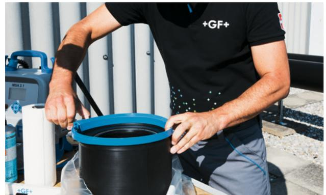
Stecken Sie die Montagehilfe auf das Fitting. Dehnen Sie damit die Dichtlippe durch Zusammendrücken der Griffe.
