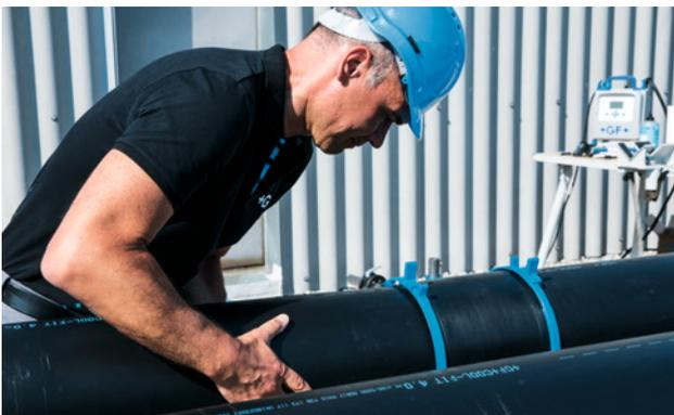
Schieben Sie beide Rohrenden bis zur Markierung in das Fitting. Ziehen Sie die Montagehilfe danach wieder ab.
