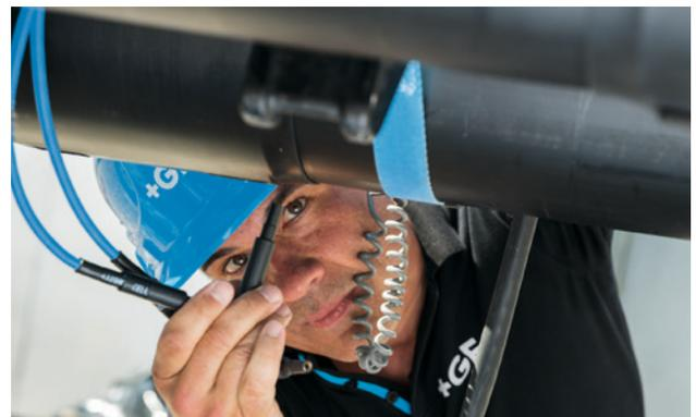
Verbinden Sie die Schweisskabel mit den Schweisskontakten des Fittings und schweissen Sie gemäss Anleitung.
