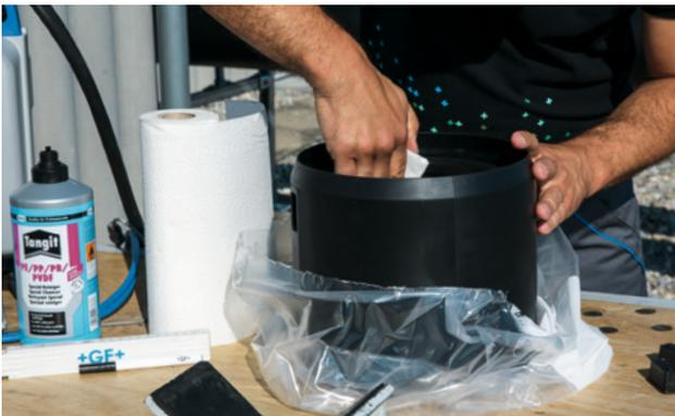
Reinigen Sie die Schweissflächen des Fittings und der Rohre mit dem PE-Reiniger Tangit und einem sauberen Tuch.
