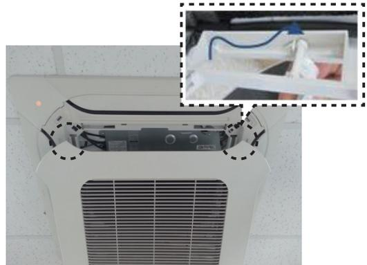
Einbauen der Rostverbindung am Bedienungsfeld
