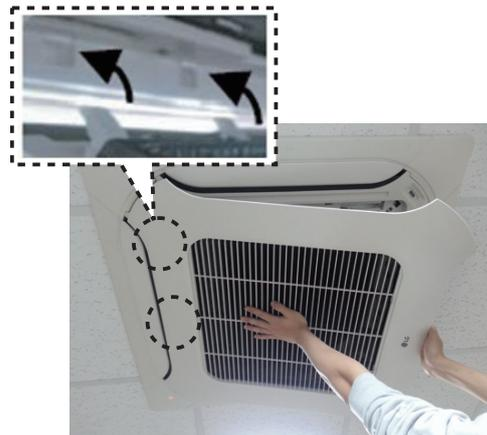
Einfügen der Kante in den Panelkörper
