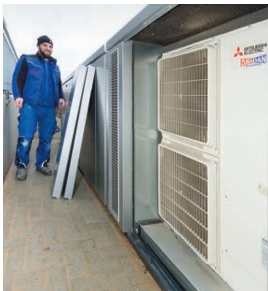
Die insgesamt sechs Luft/Wasser-Wärmepumpen sind in Kaskade geschaltet und können dadurch im effizienten Teillastbetrieb arbeiten.
