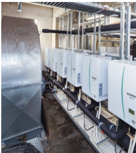
Die Innengeräte wurden in der ehemaligen Lüftungszentrale installiert.
