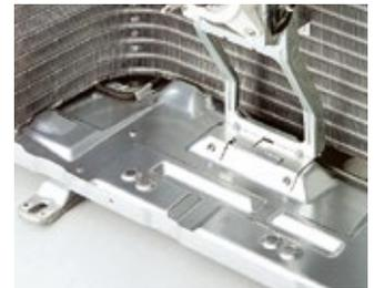
Gleicher Betriebszustand am Außengerät mit integrierter Wannenheizung
