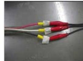
Abb. 2-7 Mit Isolierband umwickelte Klemmen
