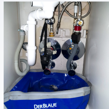
Reparatur von Eckventilen oder Siphons
