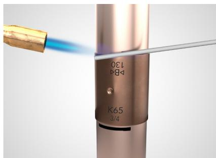
2. Verbindung erhitzen und Flussmittel auftragen.
