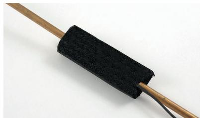
5) Den Fühler mit Isolierstoff für mindestens 10 cm an den Enden der Kappe und des gewickelten Kabels abdecken.
