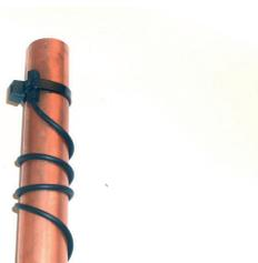
4) Das elektrische Kabel zweimal um das Rohr herumwickeln.
