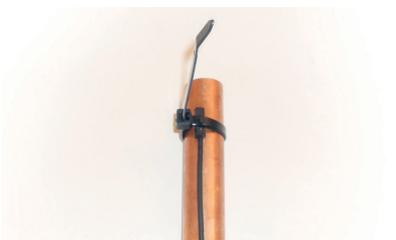
1) Den Kabelbinder um das Rohr binden und schließen.
