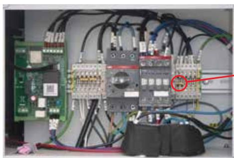
Steckbrücken an Steckplätzen CNB41 und 43 überbrücken den Digitaleingang DI2.
